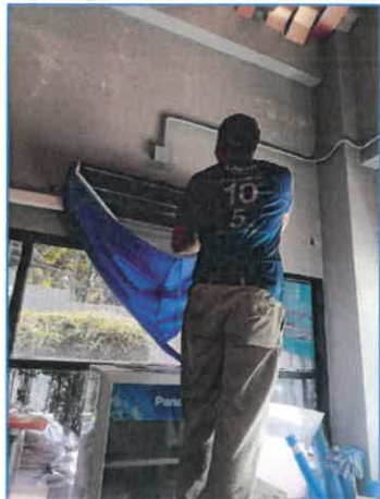
ภาพถ่ายที่ 2.2-21 การทำความสะอาดระบบปรับอากาศ
