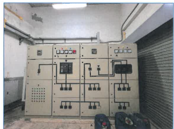
ภาพถ่ายที่ 2.2-17 ตู้ MDB และระบบ Circuit Breaker ของโครงการ
